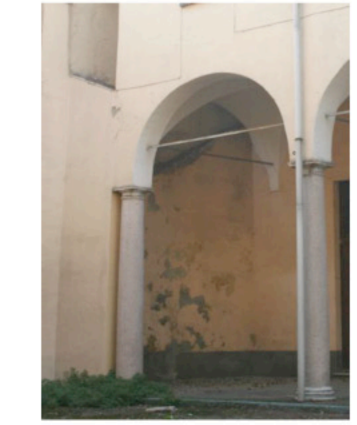
da i rilievi effettuati è emerso (da una sommaria misurazione) che le colonne hanno altezze diverse. In base alle altezze diverse delle colonne è stata in passato cerchiata e ricostruita con del cemento. Questo cemento ha
