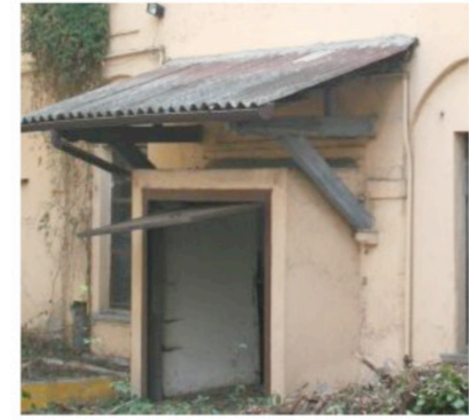
L'intonaco sulla facciata è di tipo rustico, ripreso e tinteggiato più volte, la tettoietta ha struttura in legno poggiate su elementi in pietra tinteggiati
