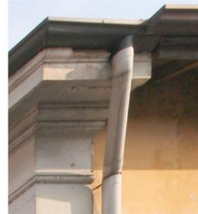
Particolare delle lesene orizzontali realizzate con mattoni e modellate in opera con malta di cemento, ricoperta da pitture successive. Come per gli altri elementi, il dilavamento e l'attacco chimico dovuto agli agenti atmosferici, il degrado per azione del gelo /disgelo, hanno portato al degrado sia delle tinteggiature sia dell'intonaco in più porzioni.
