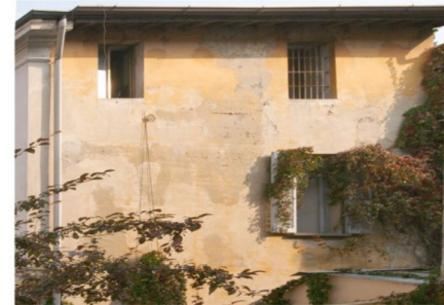
Particolare dell'intonaco realizzato con più strati sovrapposti su base di muratura in mattoni. Come per gli altri elementi, l'attacco biologico e chimico dovuto agli agenti atmosferici e la cristallizzazione dei sali all'interno degli elementi hanno portato alla fessurazione dell'intonaco ma anche a fenomeni di esfoliazione con conseguente distacco di uno o più strati superficiali.
