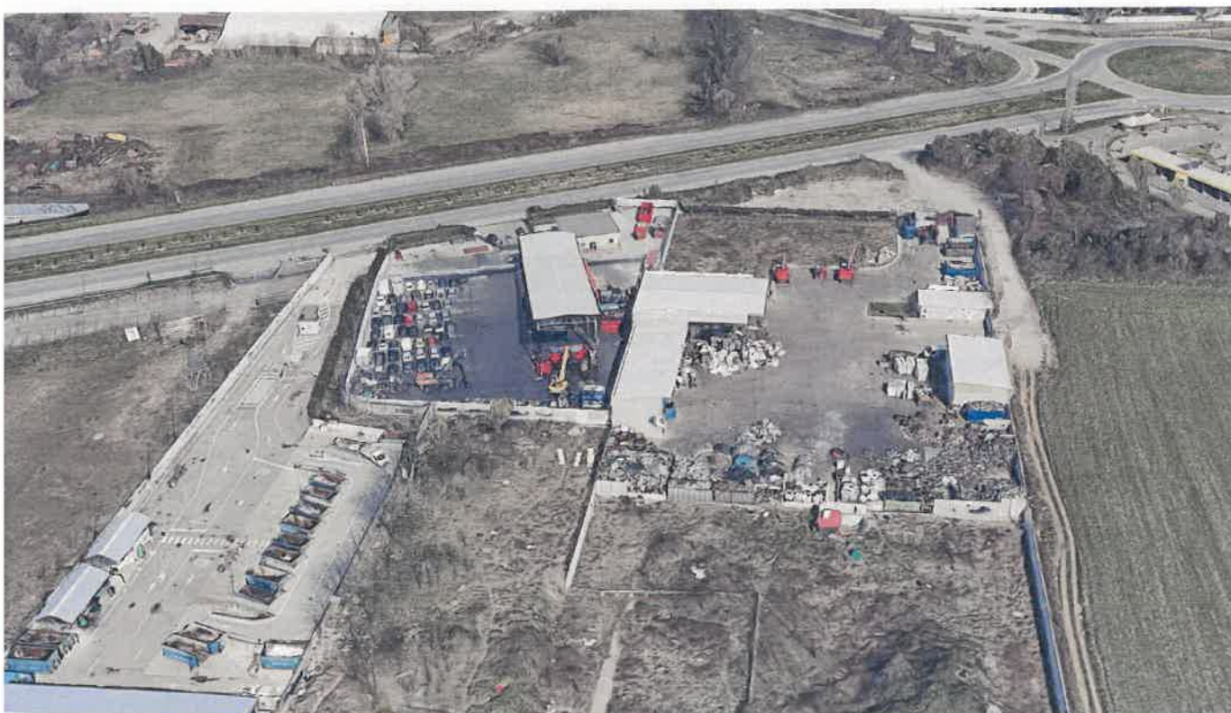
VISTA AEREA 3D - veduta da sud
