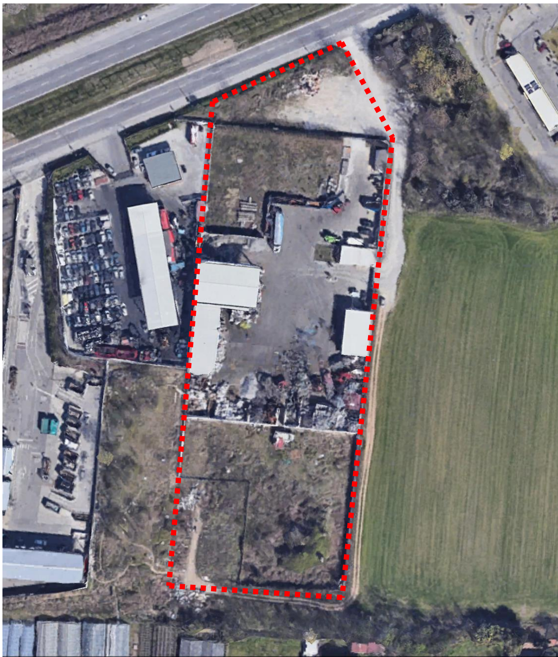
figura 4-2 situazione attuale (fonte: google earth, immagine del 02.03.2021)
