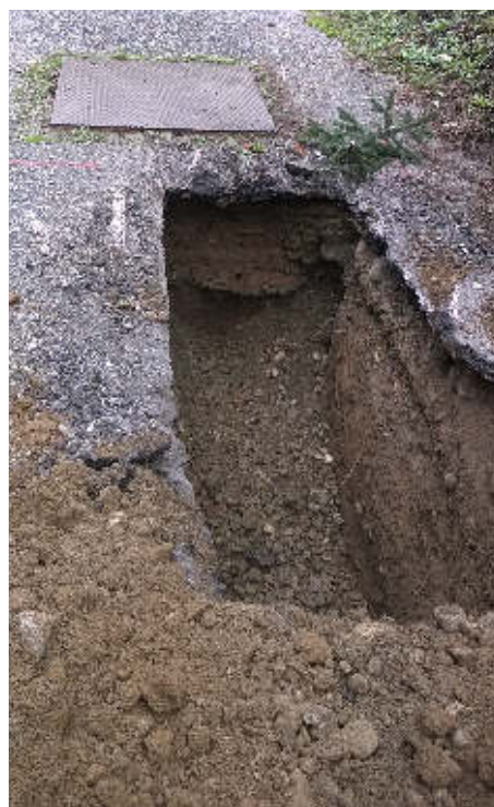
Scavo con individuazione del serbatoio cilindrico
