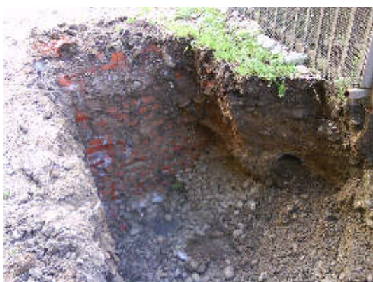
Scavo ed individuazione del serbatoio a circa 1,5 metri di profondità
