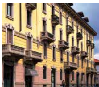
35. via Mentana, 29 Casa di civile abitazione Anno: inizi XX secolo
