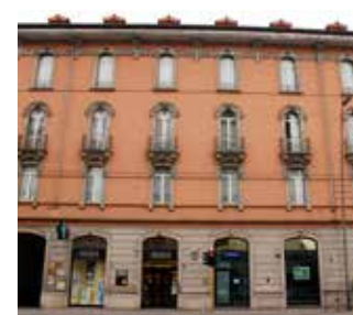
25. viale Libertà, 19 Casa Sanpietro Anno: 1906 Prog: Ing. Emilio Colombo Com: Carlo Sanpietro Impr: Carlo Sanpietro Rif: ACM 393/25bis
