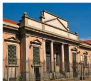
20. via T. Grossi, 9 Palazzina uffici Pastori & Casanova Anno: 1928-1930 Prog: Ingg. G. Maggi, G. Carera Com: Tessitura Pastori & Casanova
