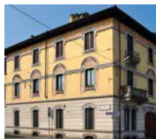
38. via G. Raiberti, 14 Casa Levati Anno: 1904 Prog: Ing. Luigi Osculati Com: F.lli Levati fu Romualdo Impr: Ambrogio Fossati Rif: ACM 389/5
