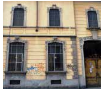
1. via Aliprandi, 21 Cabina elettrica Ponti Anno: 1926 Prog: Ing. Archimede Canali Com: soc. an Imprese Elettriche Rif: ACM 443/34
