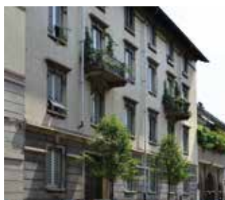
18. via G. Giulini, 4 Casa di civile abitazione Anno: inizi XX secolo
