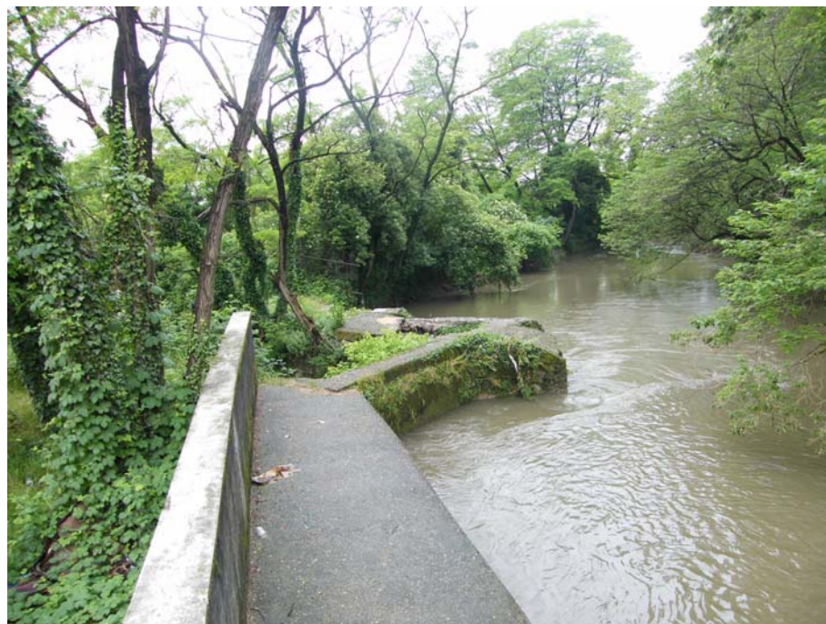
Foto 18: presa della Roggia Lupa
