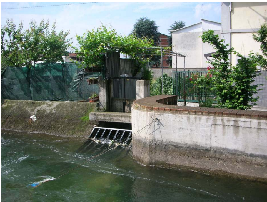
Foto 44: presa Derivatore Villoresi
