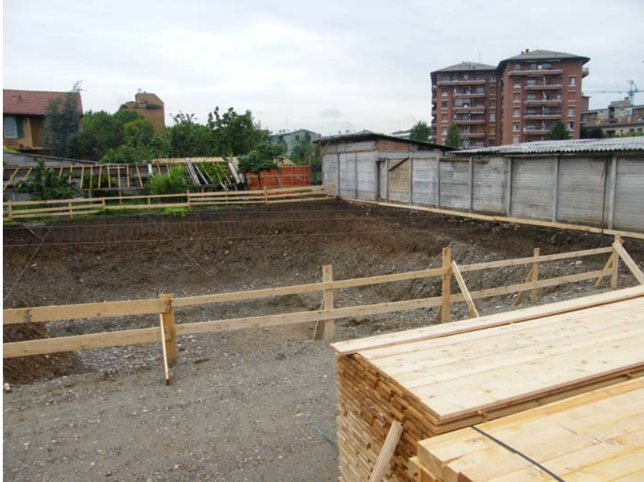
Foto 23: scavo edile lungo Via Pier della Francesca
