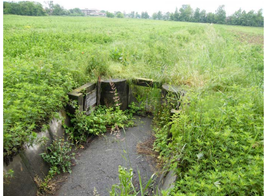
Foto 28: manufatto lungo il canale 10 VLL
