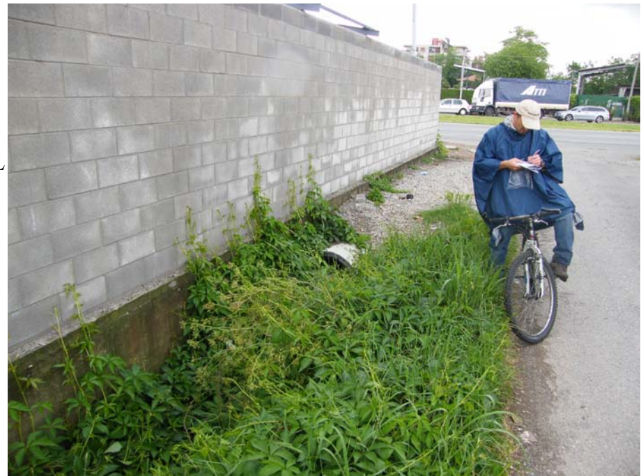
Foto 38: canale 1A VLL a sud del Viale delle Industrie
