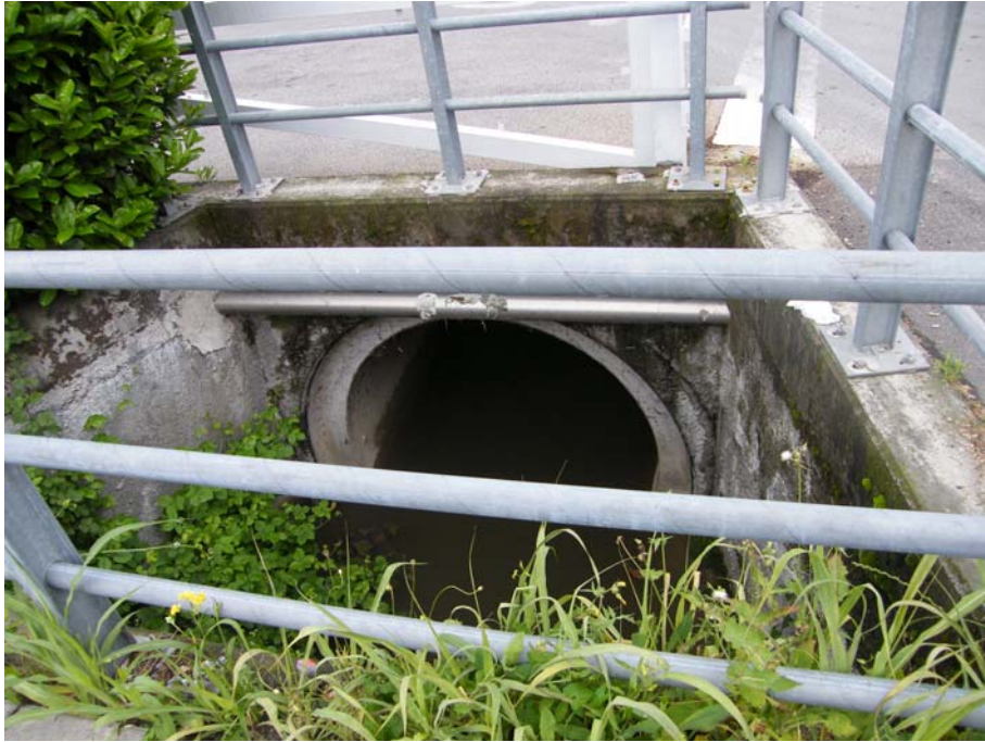
Foto 41: Roggia Molinara all'ingresso dell'area del depuratore
