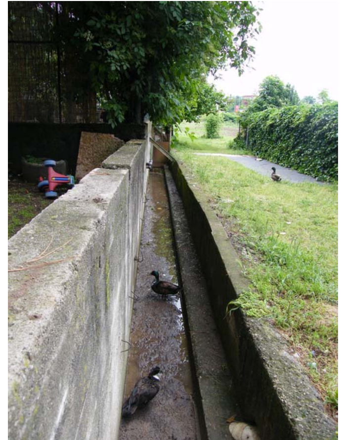
Foto 30: tratto terminale di adacquatrice con recapito in fognatura
