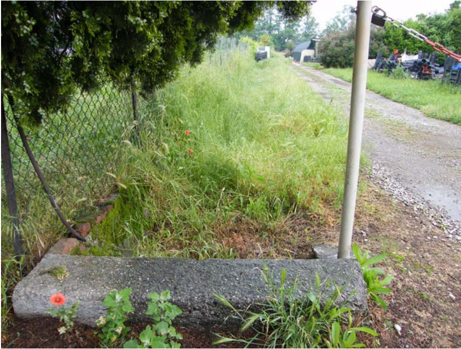
Foto 3, 4: Canale 1/AVLP - percorso di adacquatrice dismessa e relativo manufatto di presa dal canale principale
