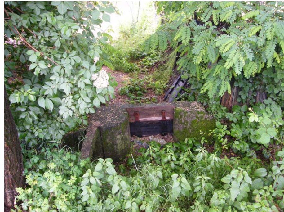
Foto 3, 4: Canale 1/AVLP - percorso di adacquatrice dismessa e relativo manufatto di presa dal canale principale
