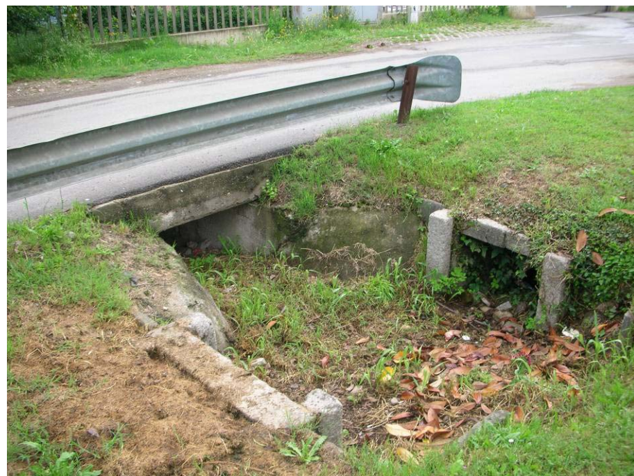
Foto 53: manufatti di derivazione abbandonati lungo adacquatrice dismessa
