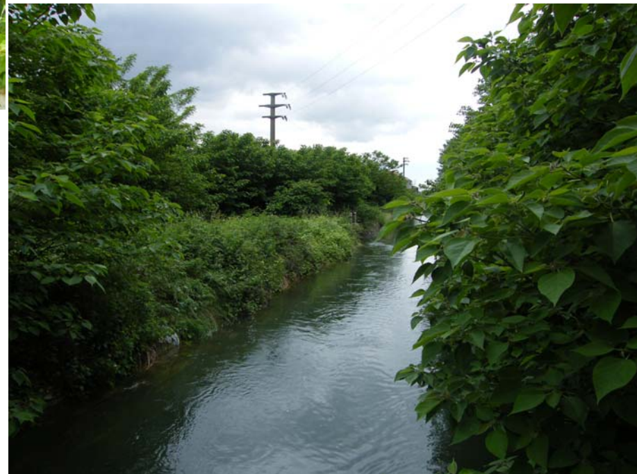
Foto 36: presa del canale 2A VLL
