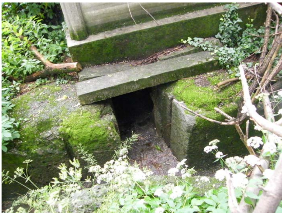
Foto 32, 33: manufatti di derivazione attivi e dismessi su adacquatrice alimentata dal canale 1/A VLL
