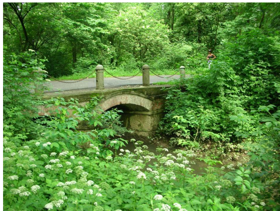
Foto 55: ponte sulla Roggia dei Molini asciutti
