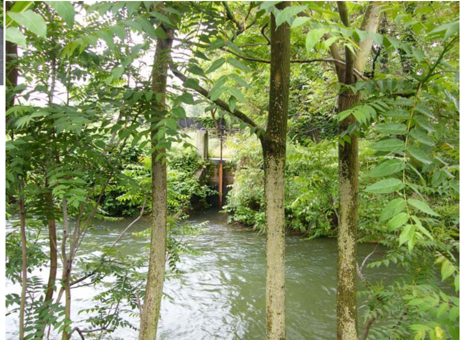
Foto 10: presa del canale 1/C VLP
