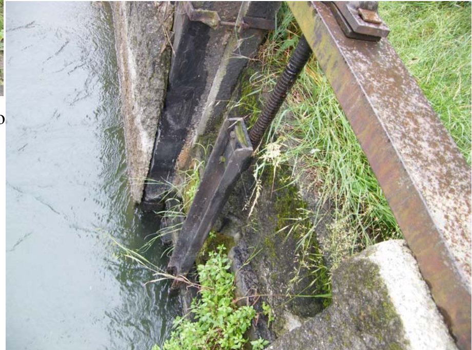
Foto 20: presa del canale 10 VLL
