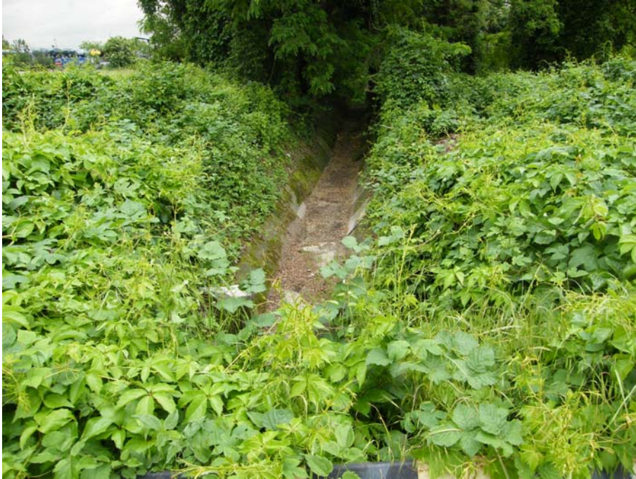
Foto 35: alveo del canale 2A VLL
