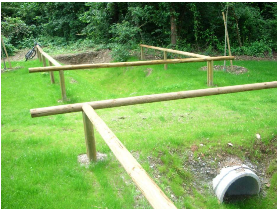
Foto 54: attraversamento fosso di nuova realizzazione nel Parco di Villa Reale
