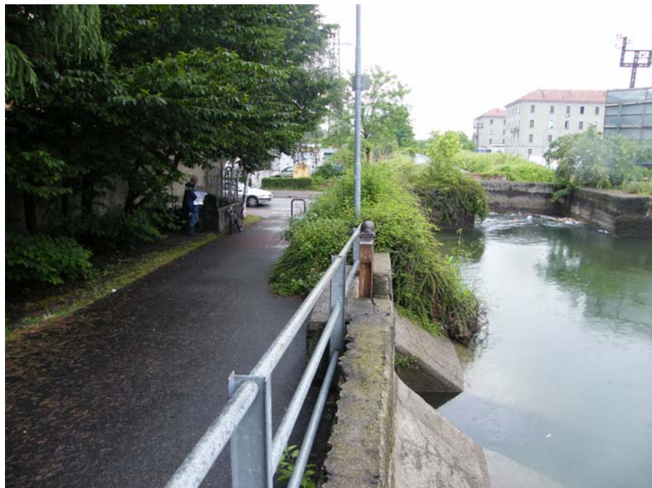
Foto 21: presa del canale 1/A VLL
