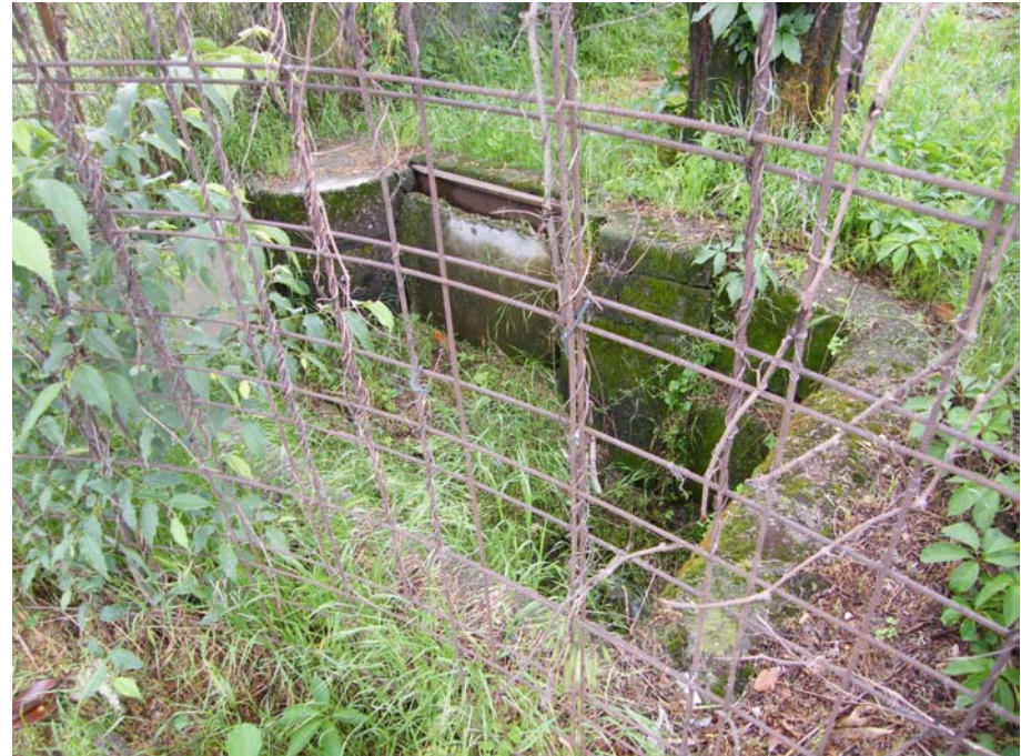
Foto 12: ultimo manufatto partitore visibile sul canale 1/CVLP
