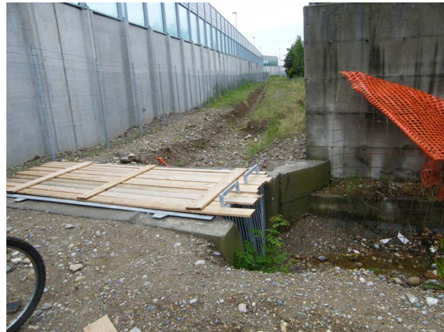
Foto 34: canale 1/A VLL all'altezza dell'attraversamento della A4
