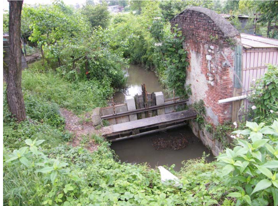
Foto 42: presa della Roggia Molinara sul fiume Lambro
