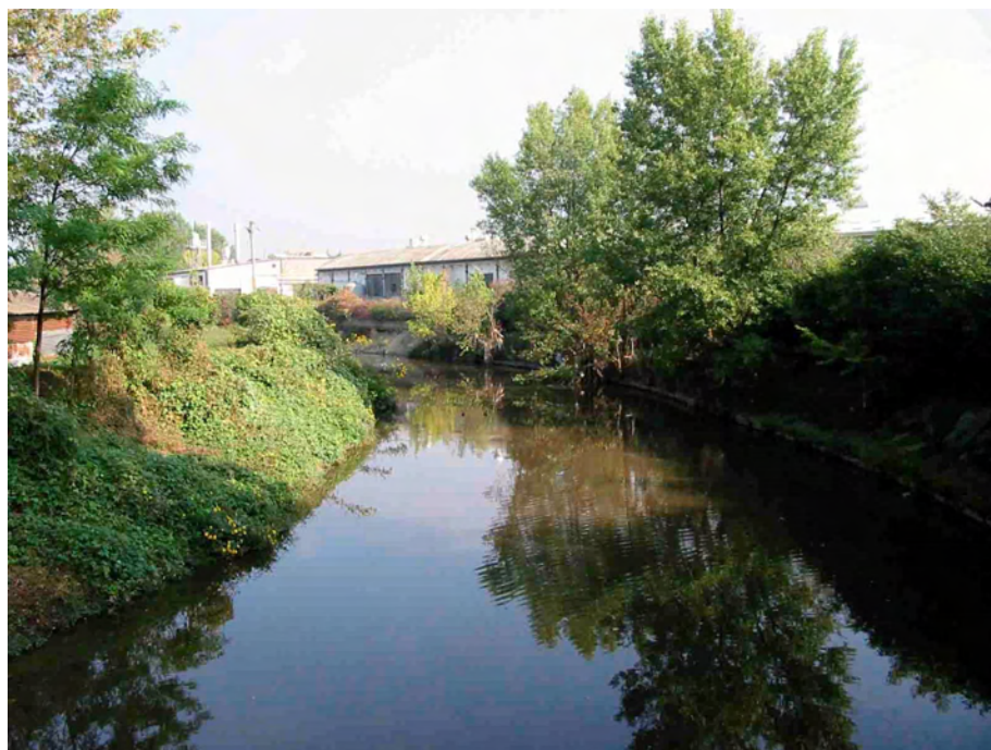
Figura A5.1 – Sponde in cemento del Lambro all'ingresso del confine nord del Parco (foto 2)
