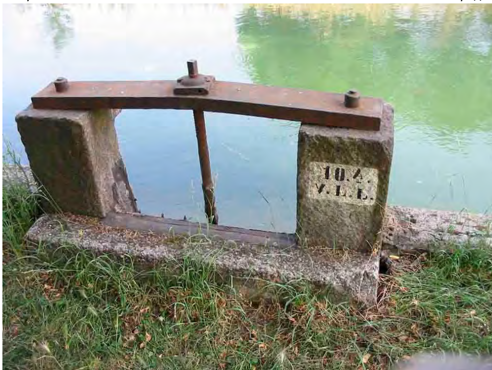
Figura A5.1 – Chiusa di derivazione sul Canale Villoresi
