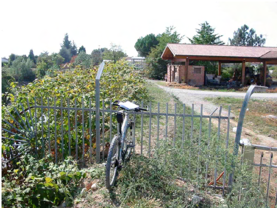
Figura A5.4 - Accesso all'argine impedito. Sponda opposta al depuratore (foto 38)
