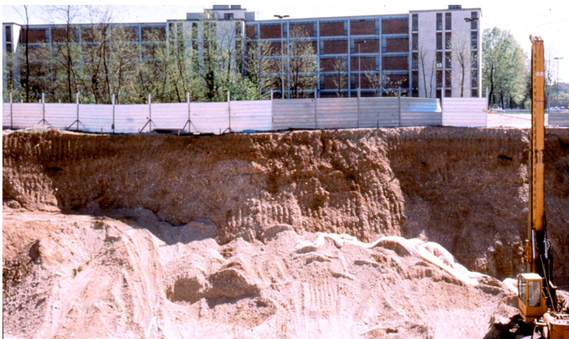
Figura A6.1 – Scavi per la costruzione dell'Ospedale S.Gerardo. Sono visibili alcune cavità nelle ghiaie (foto P.Casati 1997)
