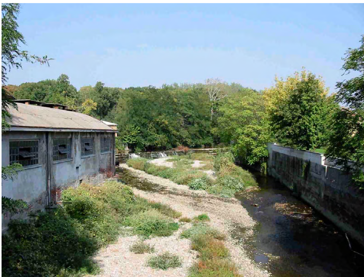
Figura A5.1 – Area industriale dismessa e traversa poco a valle del Ponte delle Grazie (foto 1)
