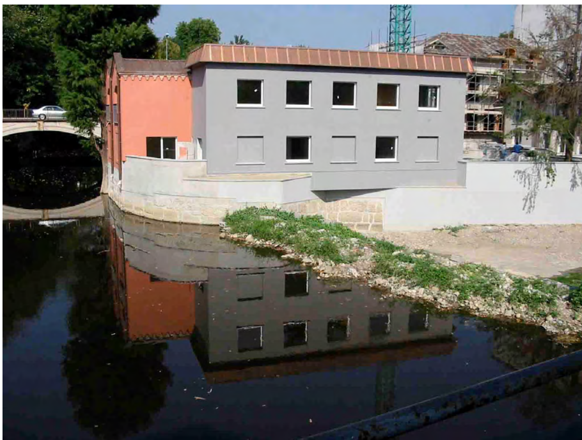
Figura A5.2 – Ristrutturazione lungo l'alveo a fianco della traversa di derivazione del Lambretto
