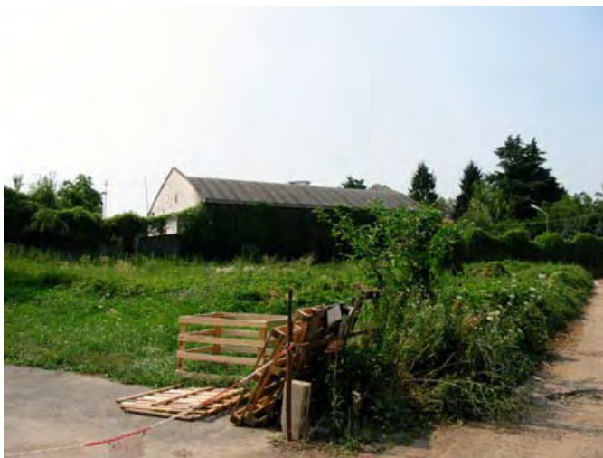
Figura A6.1 - Capannoni della Caserma IV Novembre
