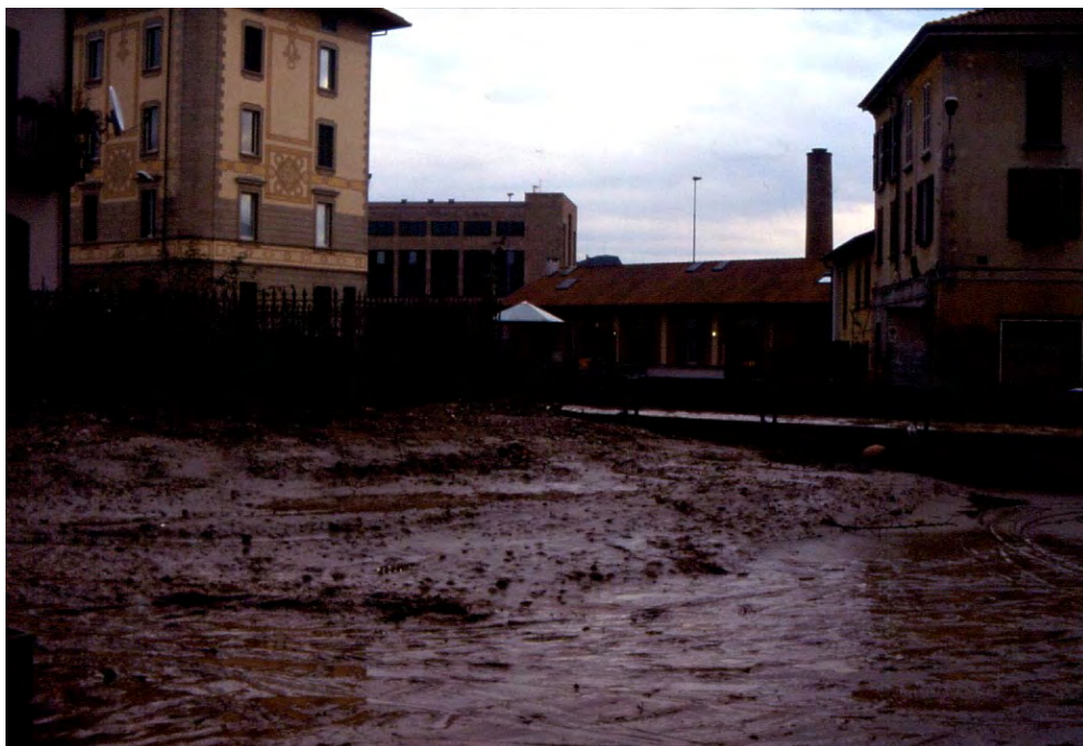
Figura A5.4 - Spalò S.Maddalena il giorno successivo alla piena. In primo piano è visibile il cumulo di materiale limoso lasciato dalle acque.
