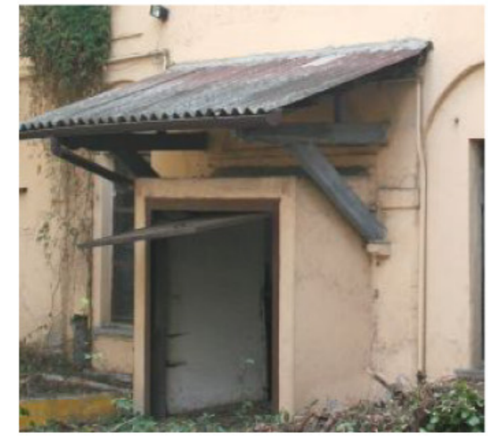
L'intonaco sulla facciata è di tipo rustico, ripreso e tinteggiato più volte, la tettoietta ha struttura in legno poggiante su elementi in pietra tinteggiati e la copertura è costituita da pannelli ondulati.
