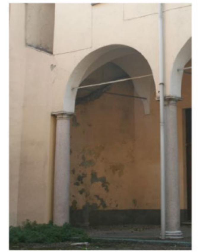
Le colonne del porticato sono in granito, i basamenti sono stati ricostruiti placando la colonna con malta cementizia che impedisce di verificare la consistenza materica del basamento originario.
