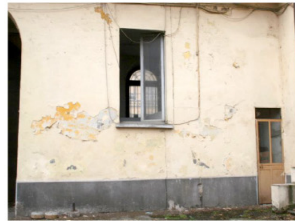
Particolare dell'intonaco realizzato con più strati sovrapposti, dovuti anche a rappezzi, rifacimenti successivi prevalentemente con malta cementizia
