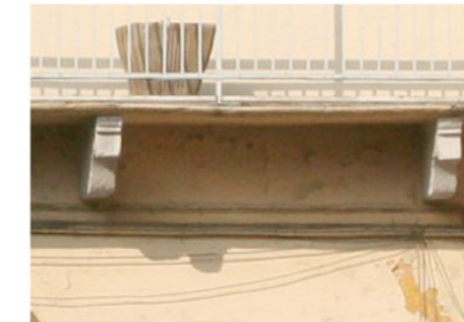
Particolare dei reggimensola in granito verniciato a sostegno del balcone
